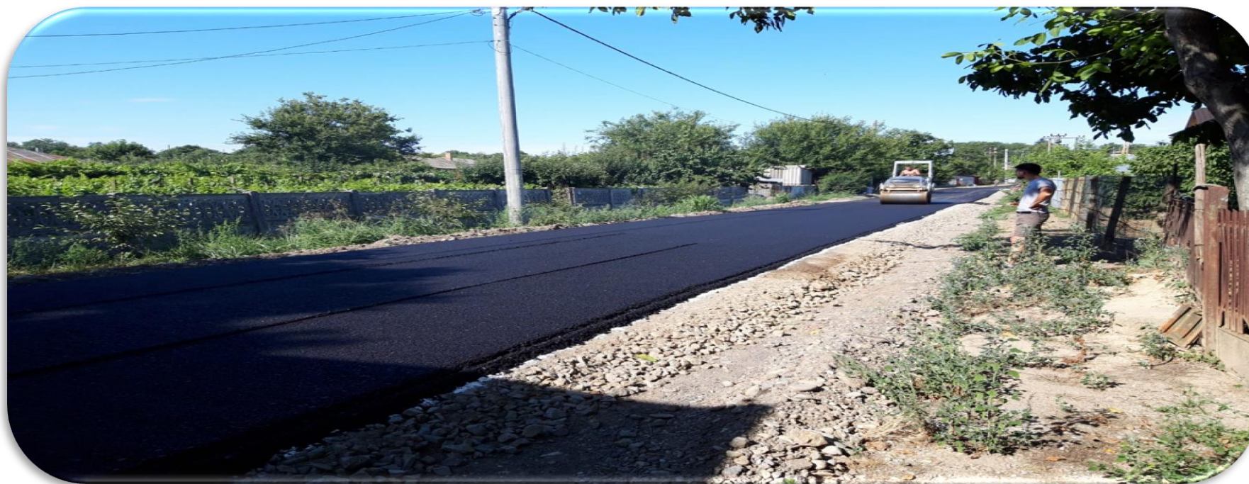
In imagine: Asfaltare drumuri interioare, Căscioarele;
