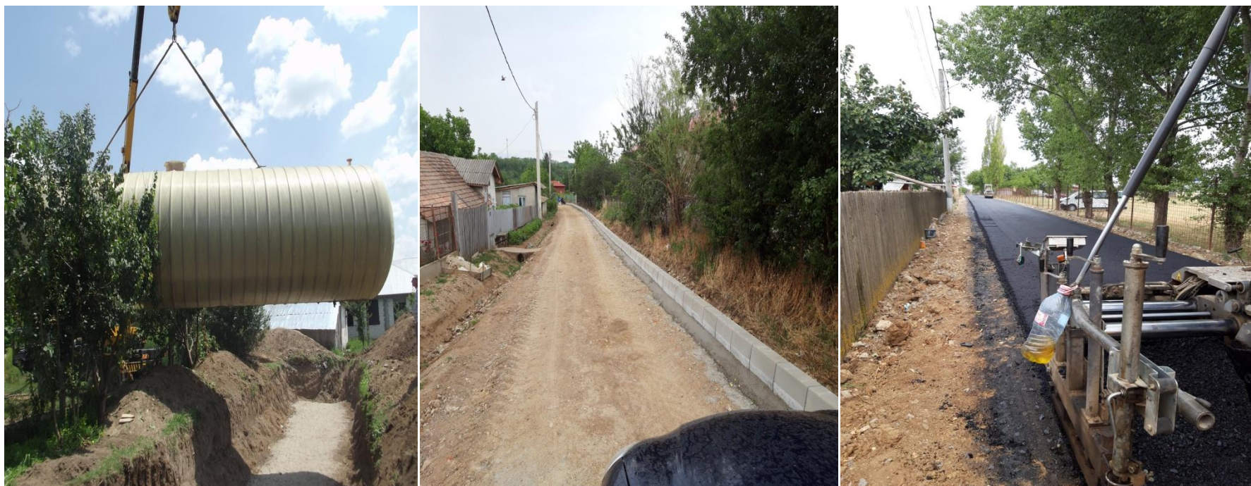
Foto: proiecte de infrastructură mare în Căscioarele – aducțiune și captare apă, modernizare și asfaltare drumuri interioare;
