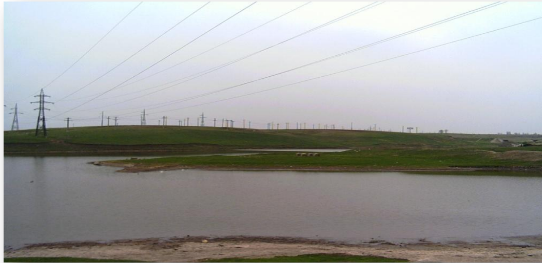
Foto - Valea Mostiștei în apropierea satului Tămădău-Mare
