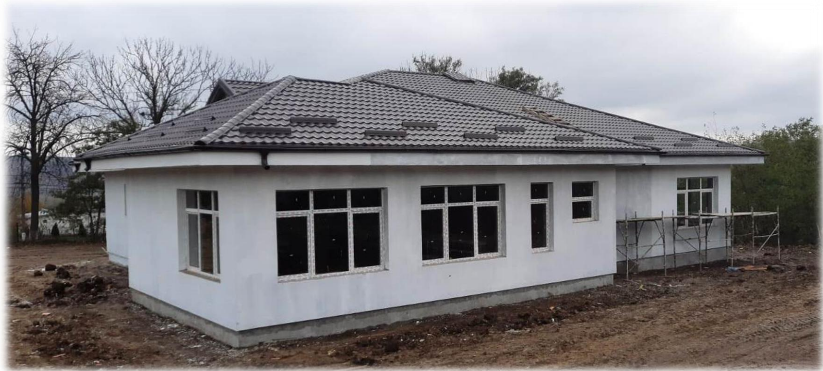
Foto: Gradinita din satul Vanatori(in constructie) –Imagine pusa la dispozitie de Primărie
