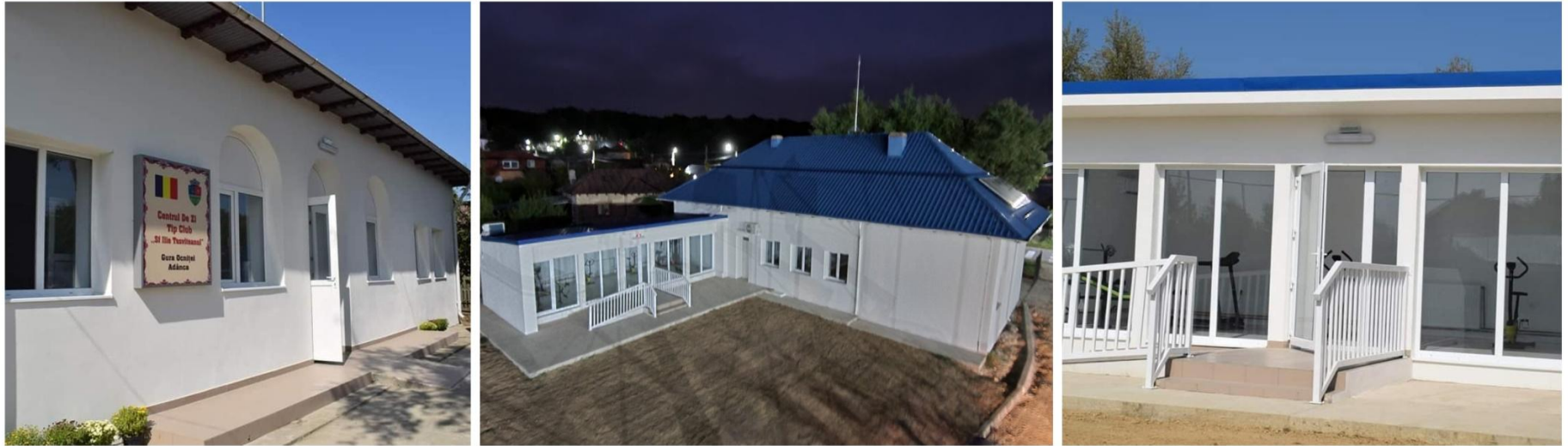
Foto: Centrul de zi; Sursa: Imagine din arhiva instituției
