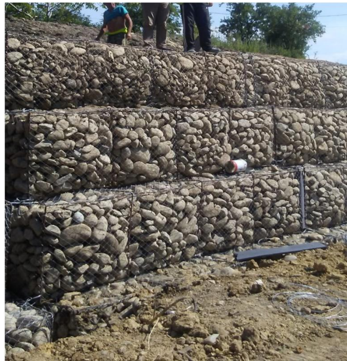
Foto: Drumri comunale si consolidare drumuri cu gambioane in com. Rădești; Sursa: Imagini puse la dispozitie de Primărie
