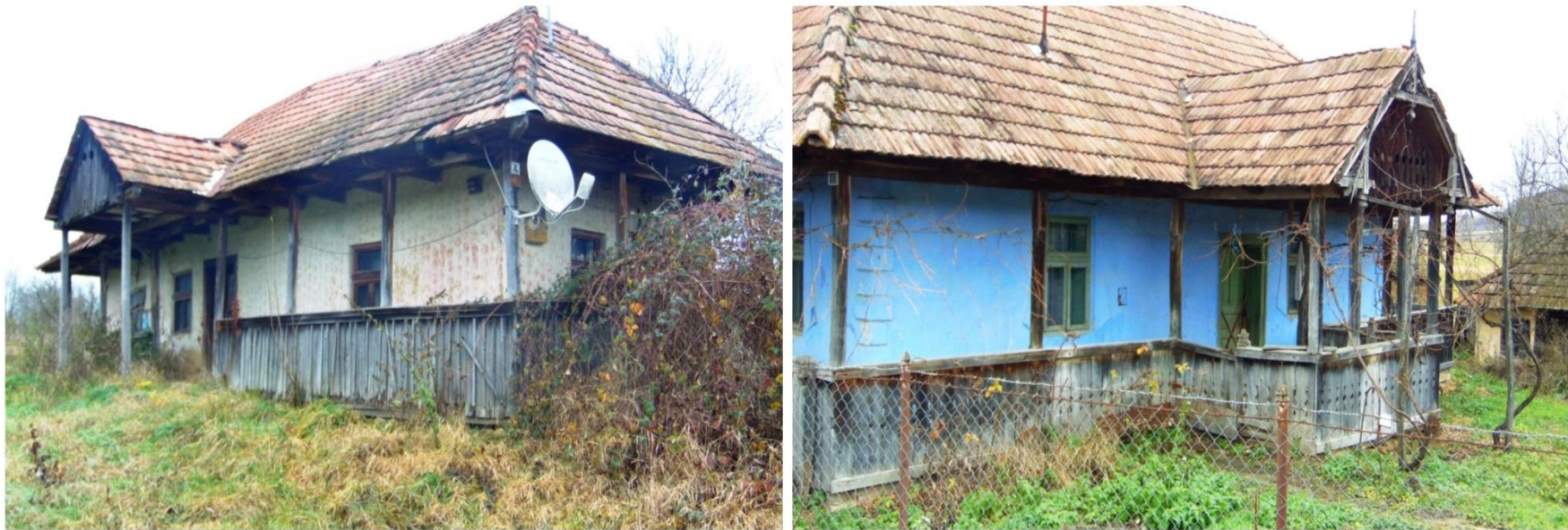
Foto: Casa veche sat Sălățiș, cu talpa împrejmuțată; Casa veche sat Bulgari, cu prispa împrejmuțată; Sursa: Imagini puse la dispoziție de primărie
