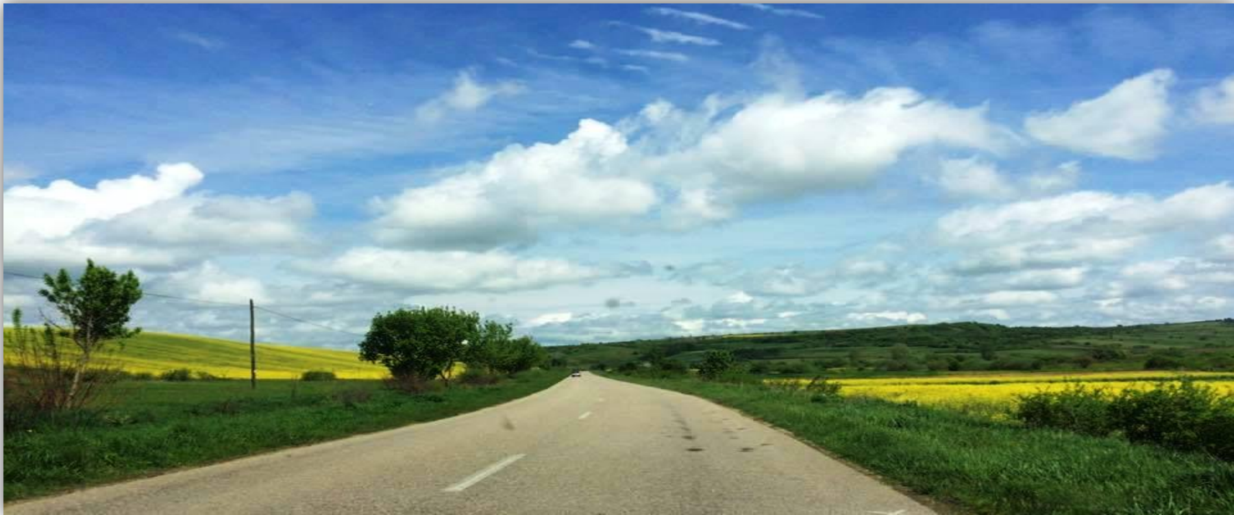
Foto: Drum comunal, com. Sălățiș – Imagine pusa la dispozitie de Primarie
